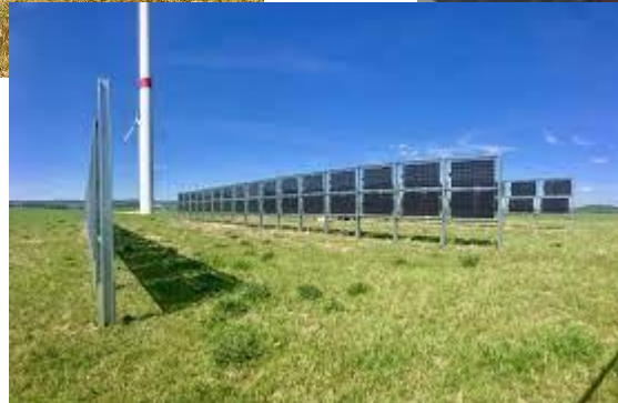
Vertikale Freiflächenanlage PV
